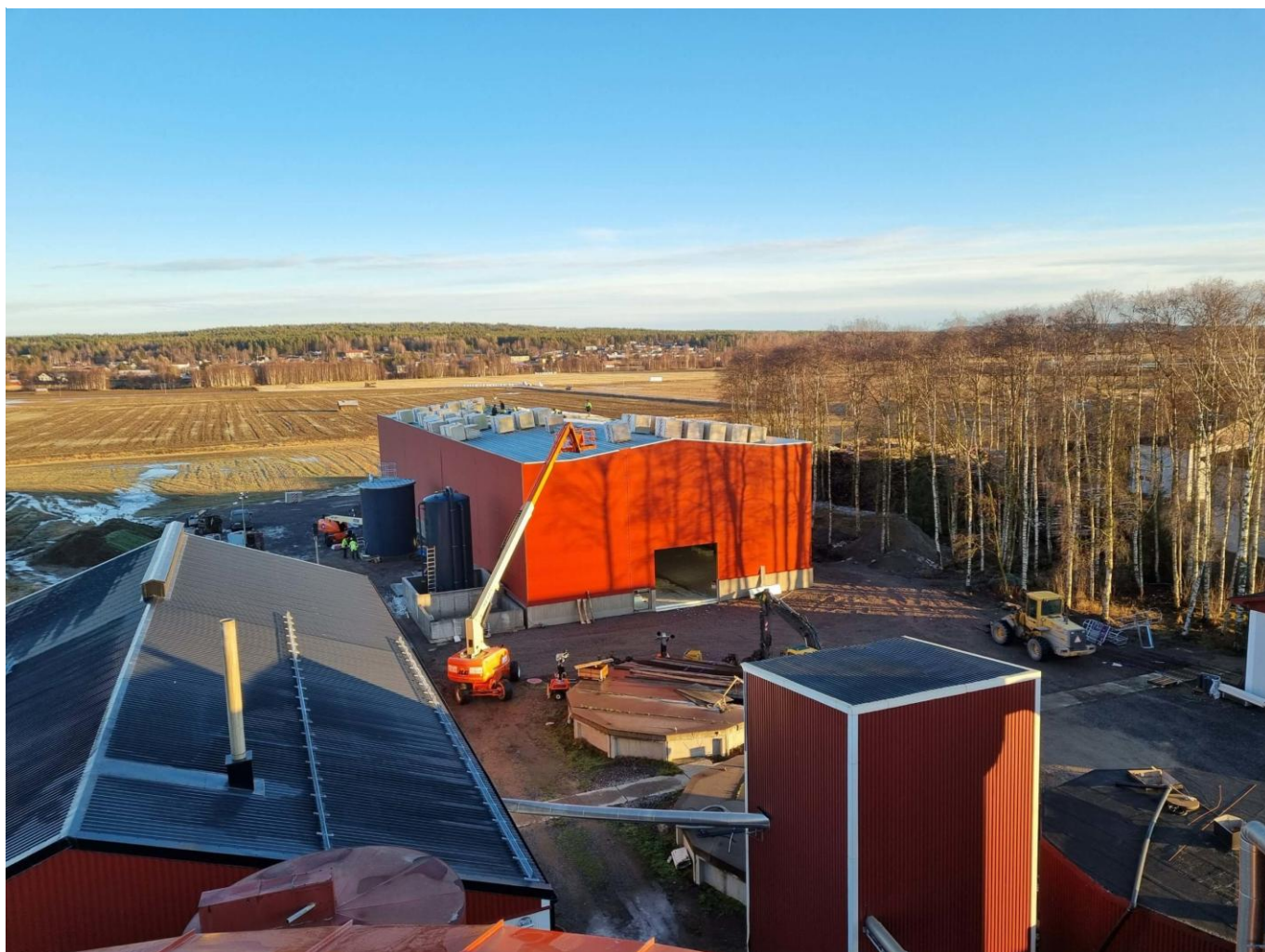
Figur 1: Alviksgården under byggnadsfasen av pelleteringsfabriken
